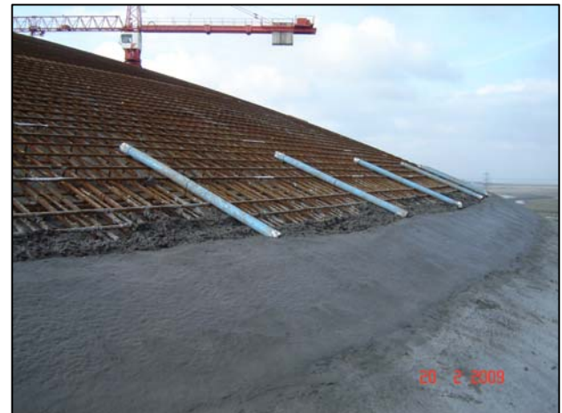
Roof Pour on Tank 4
