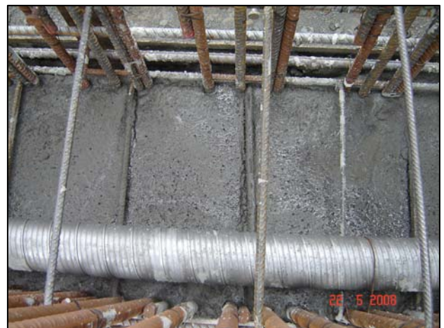
Wall Pour on Tank 4
